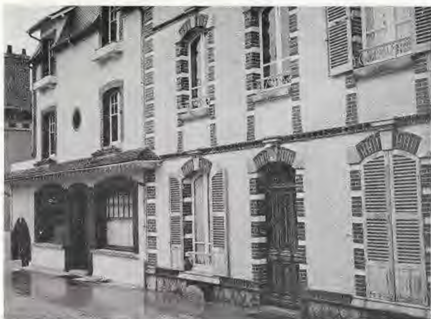
Maison de Retraite à Joigny (Yonne), 19, faubourg de Paris. Vue extérieure côté rue.
