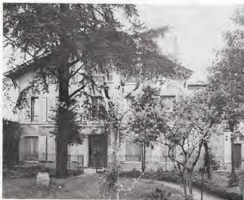
Fondation Arlette CHOTARD à Boulogne-sur-Seine, 5, rue du Transvaal. Maison de séjour pour jeunes filles de familles polytechniciennes (photo Studio JAN)
