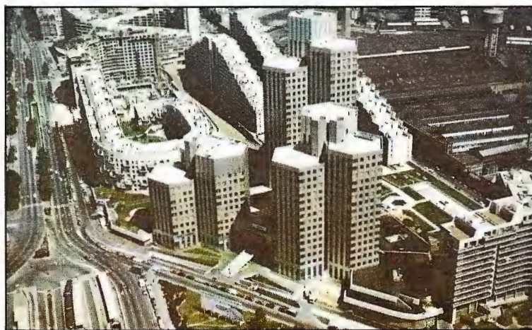
TÊTE DU PONT DE SÈVRES (Boulogne-sur-Seine). Tours de Bureaux et Bâtiments d'habitations.
